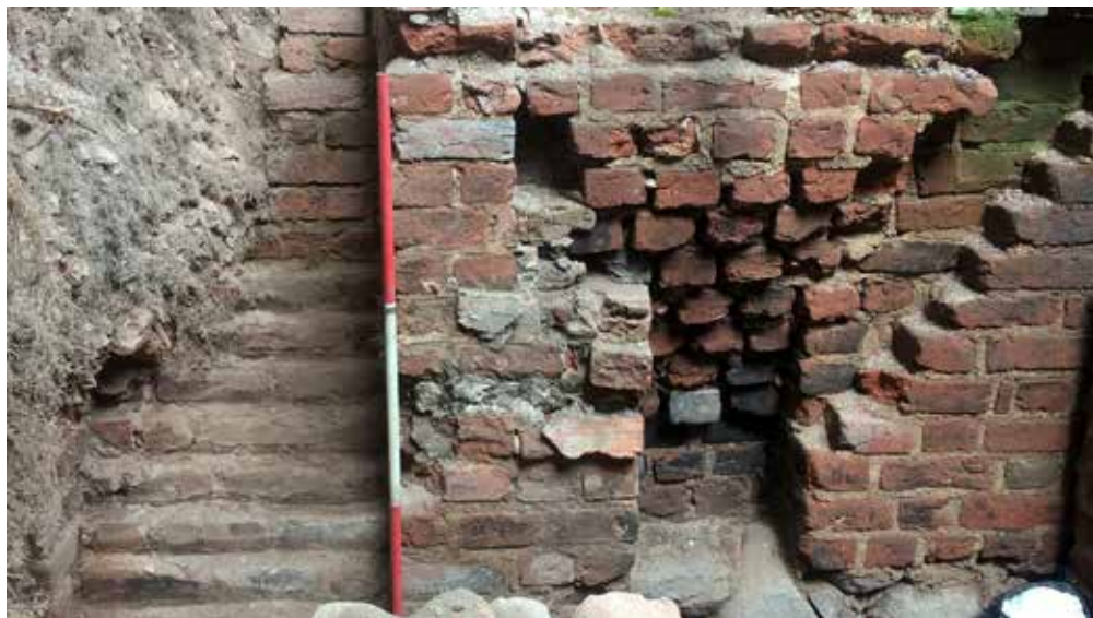
Ryc. 7. Przejmowanie, zamek średni, wykop D, mur W.079 z widocznymi przewodami wentylacyjnymi (O.282 i O.317), widok od południa. Fot. M. Żurek
