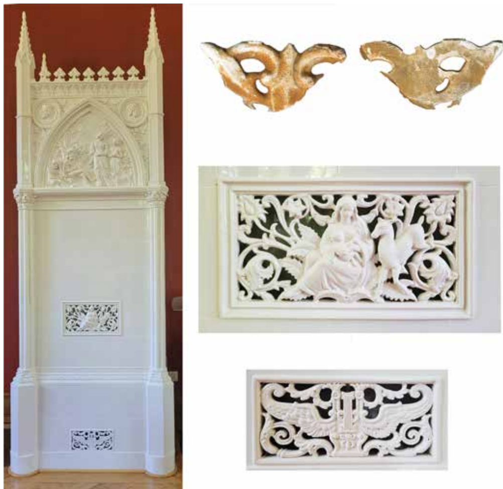
Ryc. 24. Gdańsk, ul. Łąkowa 60F, kafel płytowy wypełniający, ażurowy, nr kat. 566; ażurowe kafle do nawiewu powietrza z neogotyckiego pieca z pałacu biskupiego we Fromborku (Fabryka pieców Tobiasza Christopa Feilnera w Berlinie, 1844–1845). Fot. M. Wołyńska
