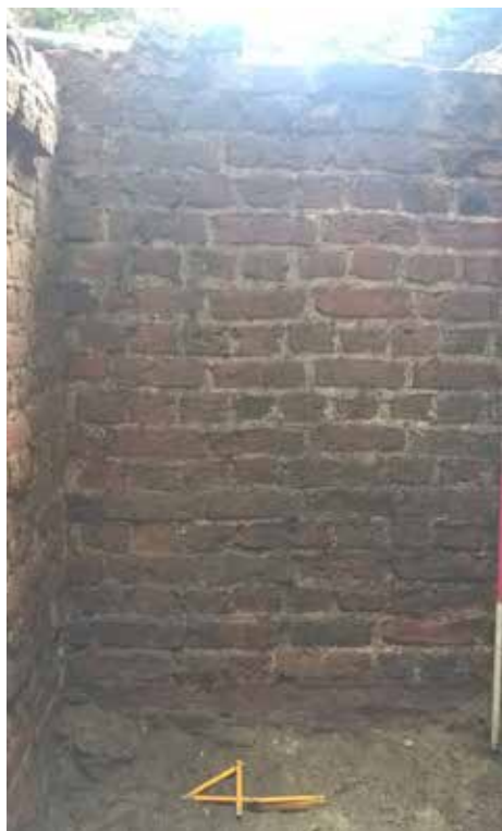
Ryc. 4. Przejazd, zamek średni, wykop L, mur W.116 i fragment posadowienia łuku na murze W.117, widok od wschodu. Fot. M. Żurek
